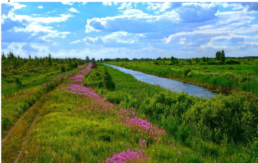
Рис. 2. Сбросной канал и дамба по южной границе заказника «Званец» Fig. 2. The discharge channel and the dam along the southern border of the reserve «Zvanets»
