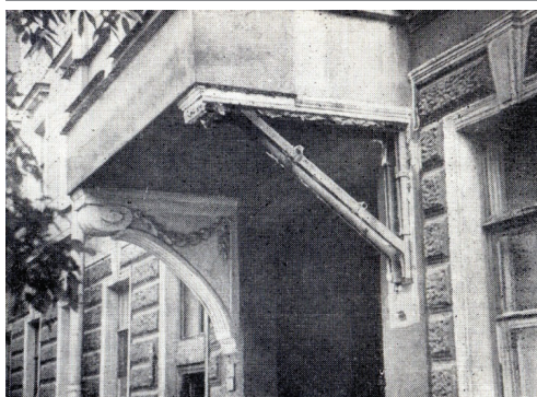
Рис. 2. Временное усиление перекрытий балконов
