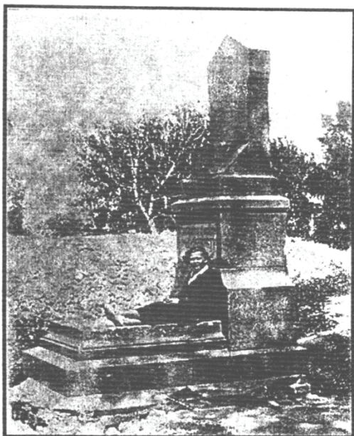
Рис. 2. Фотография разрушенного надгробия на могиле Н. М. Ядринцева. На заднем плане видны руины церкви. 12 июня 1936 г.
