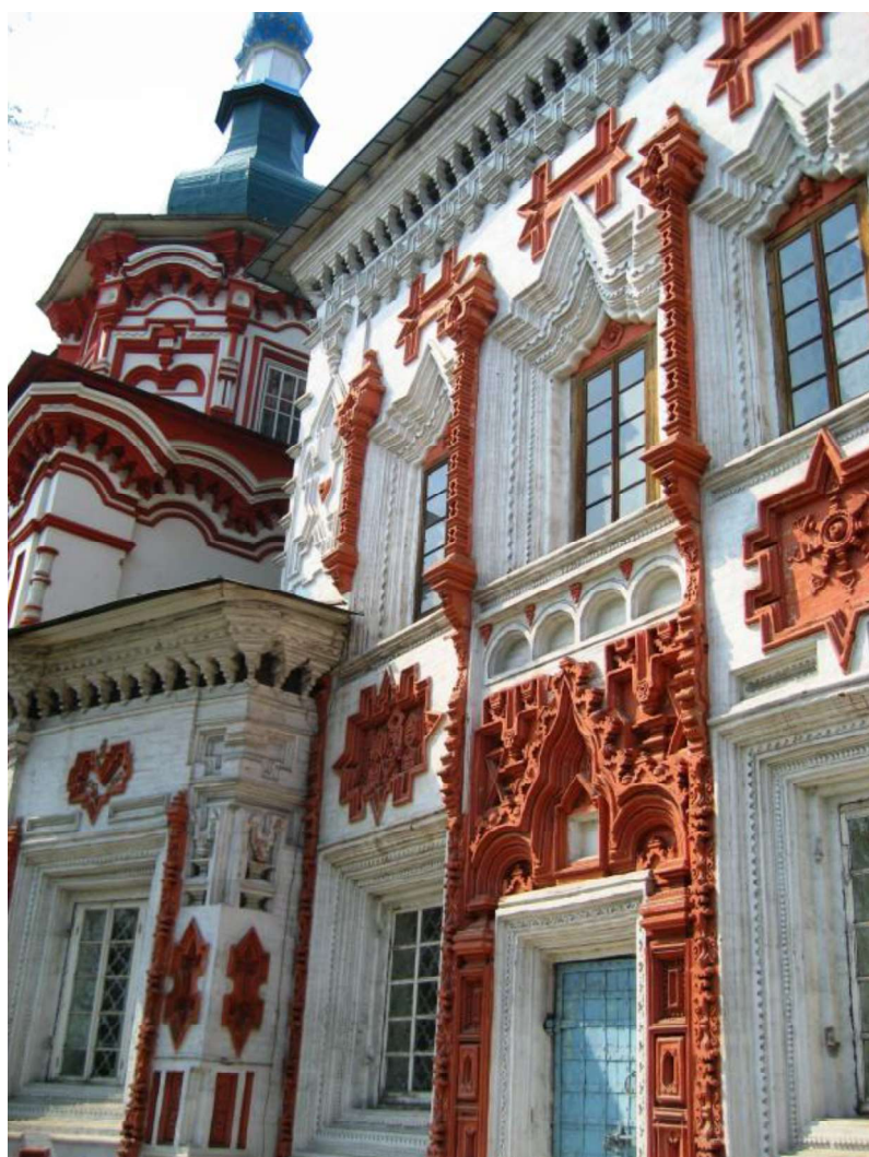
Рис. 2. Крестовская церковь. Иркутск
