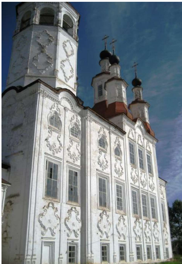
Рис. 8. Тотьма. Церковь Входа в Иерусалим
