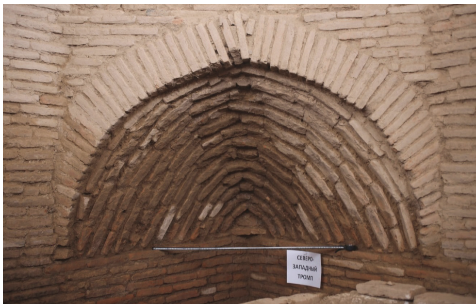
Рис. 6. Мавзолей Кёк-Таш. Тропп на северо-западном углу камеры 2
