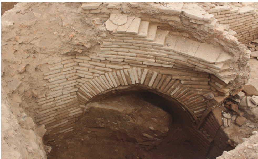
Рис. 7. Мавзолей Кёк-Таш. Сохранившаяся нижняя кладка купола над тропом
